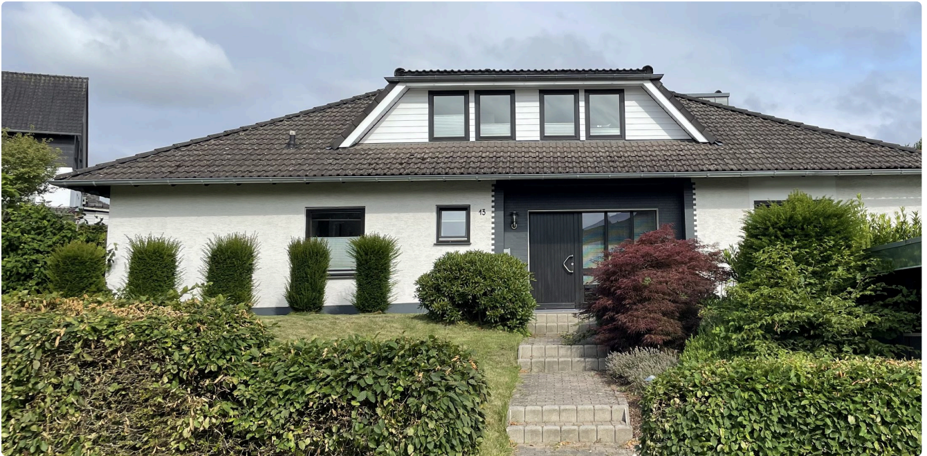
Frontansicht von der Straße
