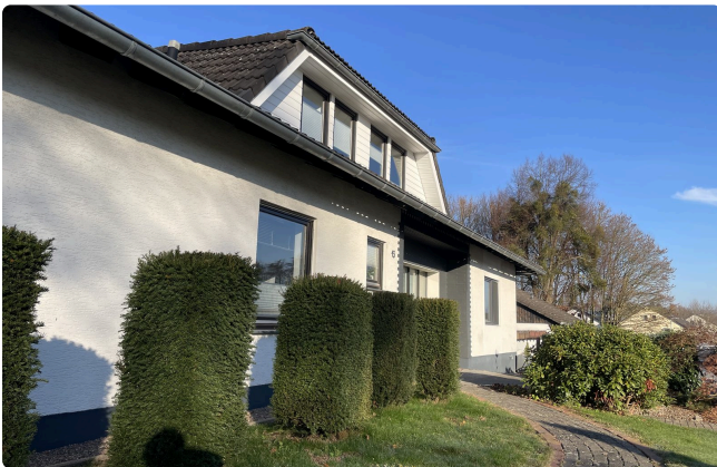
Ansicht mit Dachgaube
