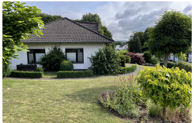
Blick vom Garten auf das Haus
